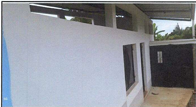
Foto 1: Rehabilitación de la cocina del centro educativo
